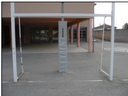
Sécurisation des cages de handball
